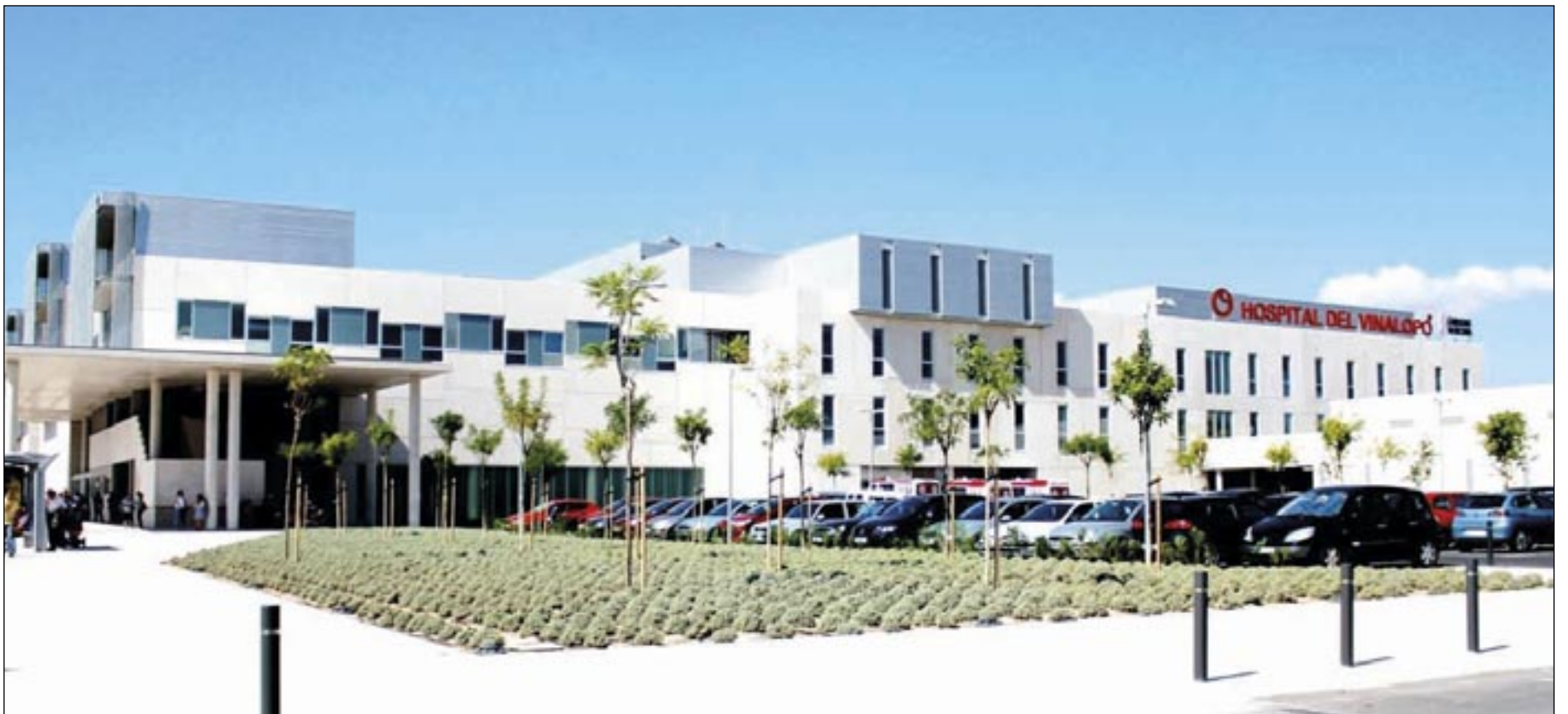
Vista general del Hospital del Vinalopó.
