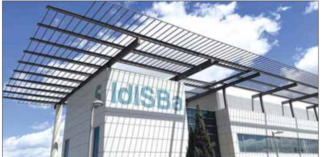
Fachada principal del edificio del IdISBa.
