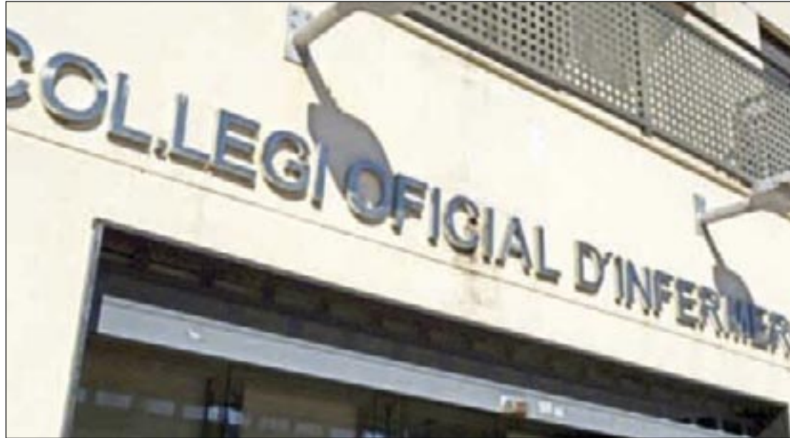
Vista general de la entrada en el Colegio.
