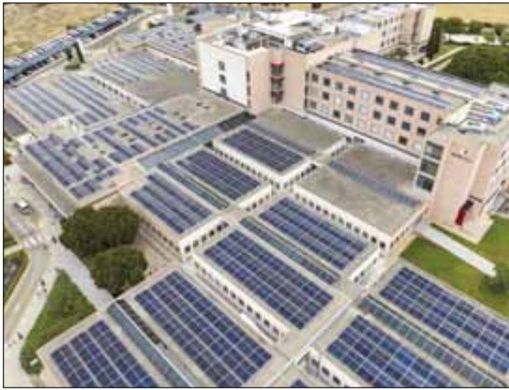
Planta de placas fotovoltaicas del Hospital Quirónsalud Palmaplanas.
